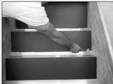
8. Ausgetretener Elchkleber sauber entfernen
