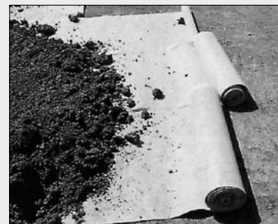
Dränage/Leckanzeige unter Mülldeponien
