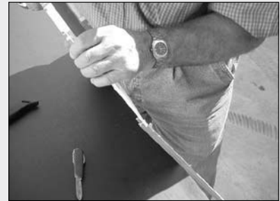
6. Kleber kopfseitig aufbringen, um ein Eindringen von Zementgemisch zu vermeiden
