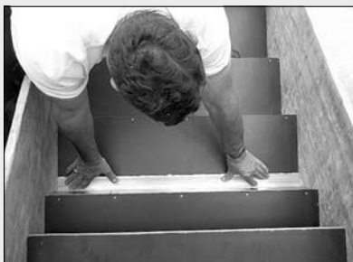
7. Profil mit starken Druck in die Form bringen
